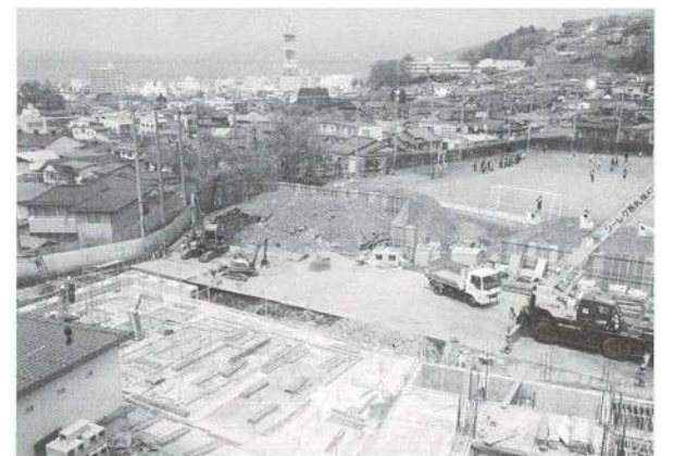
工事中の中学校校舎
