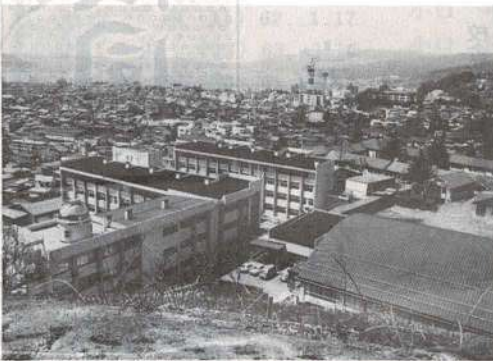
右手前 大体育館・音楽室、向こうに三沢文庫、天文ドームのあるのが東校舎、それに続いて南・北校舎。その向こうに旧校舎が見える。
