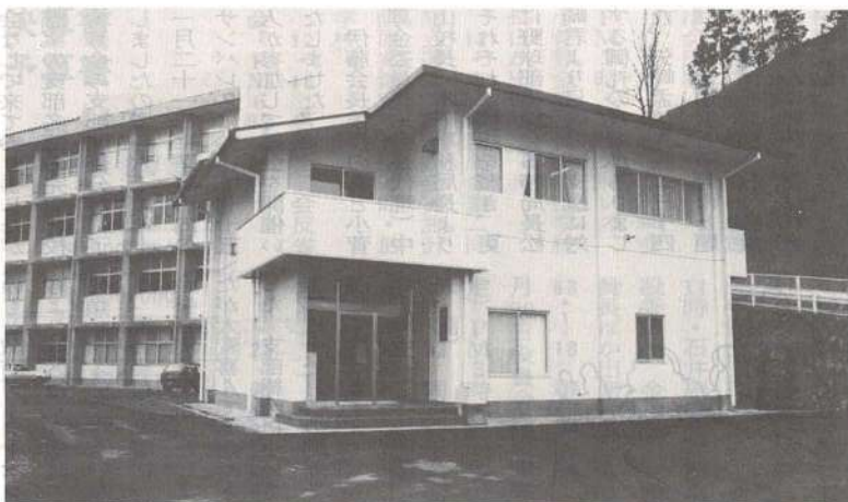
●東校舎隣に完成した鉄筋コンクリート2階建て、延べ329平方メートルの清陵会館の全景
