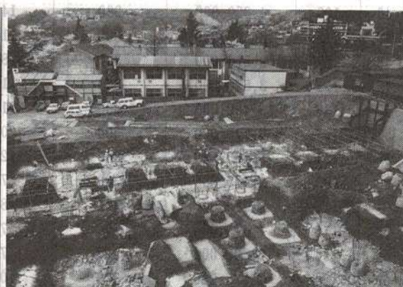
第二期工事現場と旧校舎
